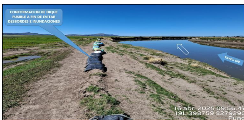
FIGURA 1 y 2: TRAMO CRÍTICO EN EL RÍO COATA, EN EL SECTOR LLUCO-CARATA, DISTRITO DE COATA, PROVINCIA DE PUNO - PUNO, NOTESE, LA MARGEN IZQUIERDA DEL RIO COATA QUE REQUIERE LA CONFORMACION DEL DIQUE FUSIBLE PARA EVITAR EL DESBORDE E INUNDACIONES EN EL RIO COATA. SE OBSERVA TAMBIEN EL AREA DE CULTIVOS AFECTADOS.
